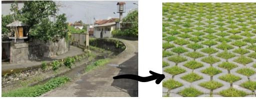
Gambar 3. Paving beton dirubah menjadi grass block
