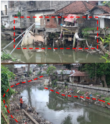
Gambar 3. Kerusakan pondasi rumah penduduk [Sumber : Observasi Lapangan, 2025]
